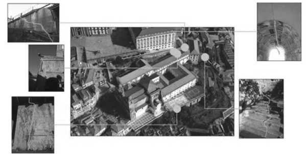
Hình 4: Sự xuất hiện các vết nứt tại khu vực ngoại thất của Nhà thờ São Lourenço
